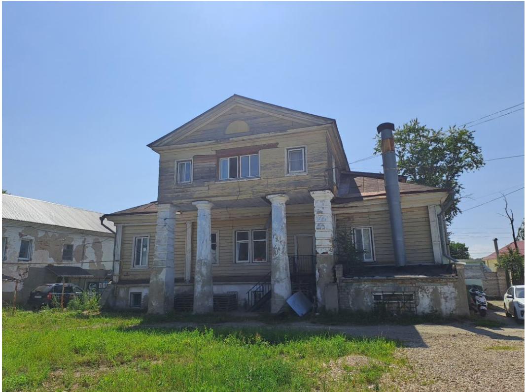
Фото 3. Объект культурного наследия регионального значения «Главный дом», перв. пол. XIX в. (Нижегородская область, г. Арзамас, ул. Ленина, 51), входящий в состав объекта культурного наследия регионального значения «Городская усадьба», перв. пол. XIX в.
